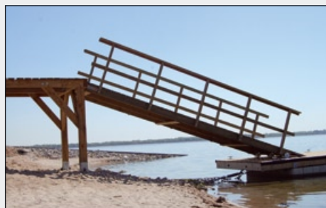
Drewniany pomost połączony jest z lądem specjalną konstrukcją
