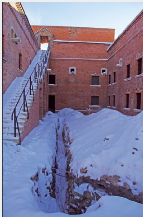
Nawet zima nie zatrzymała prac budowlanych
