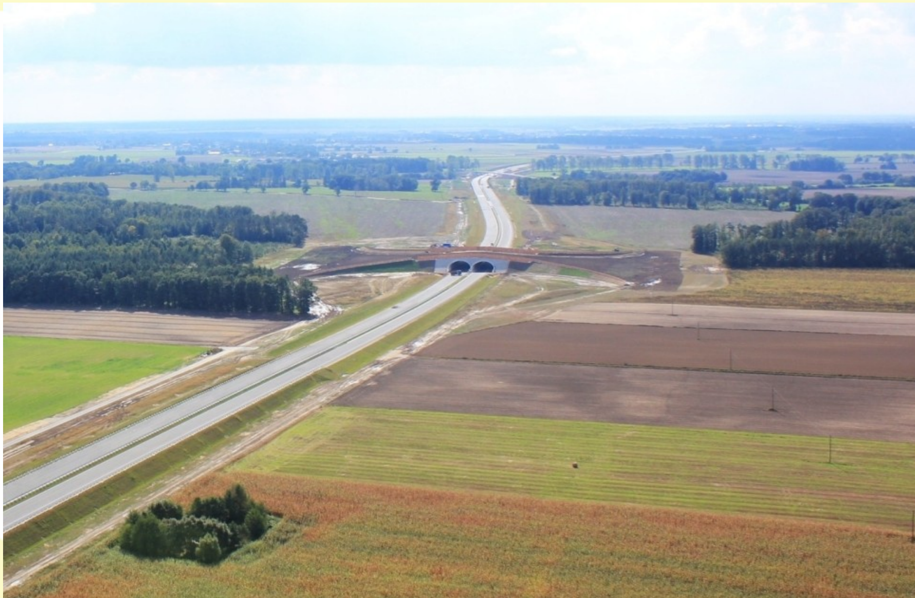
Przejście górne w ciągu drogi S-8 Wrocław-Syców (fot. GDDKiA)
