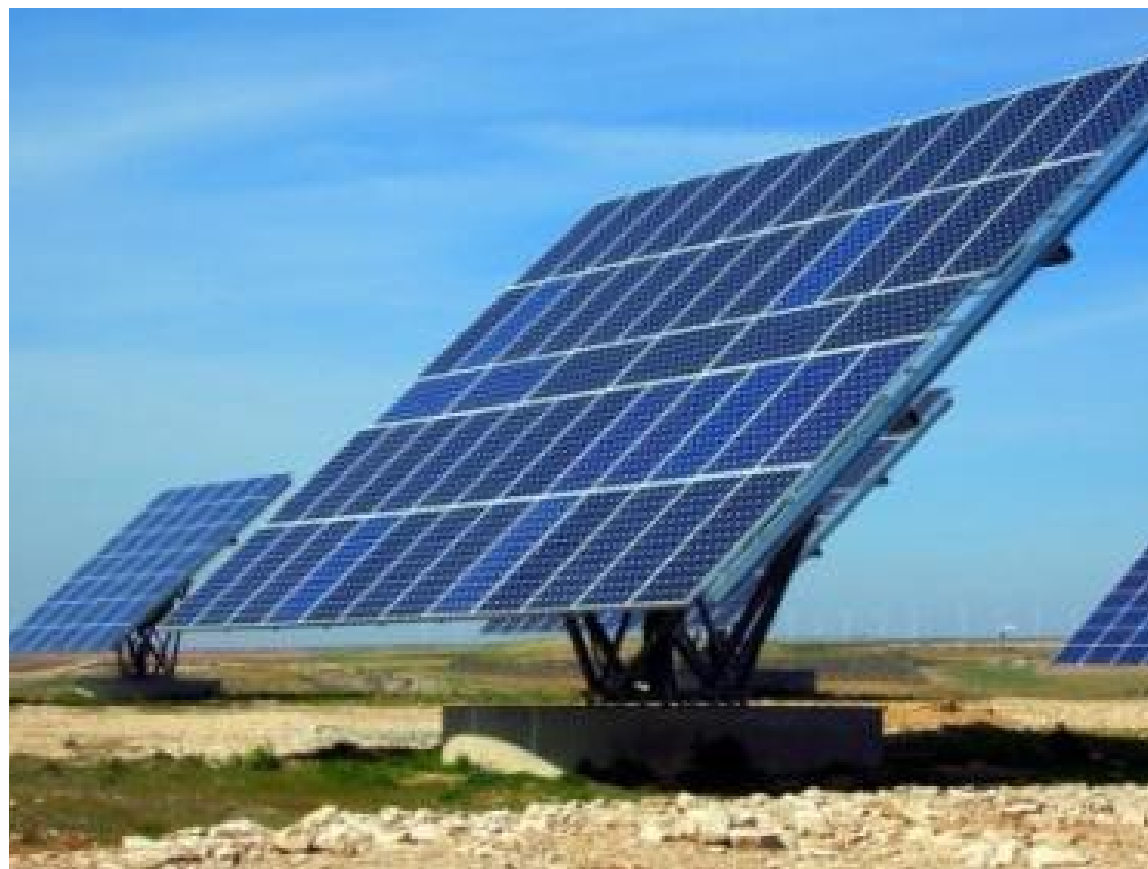
Rys. 2 System fotowoltaiczny nadążny za słońcem dwuosiowy
