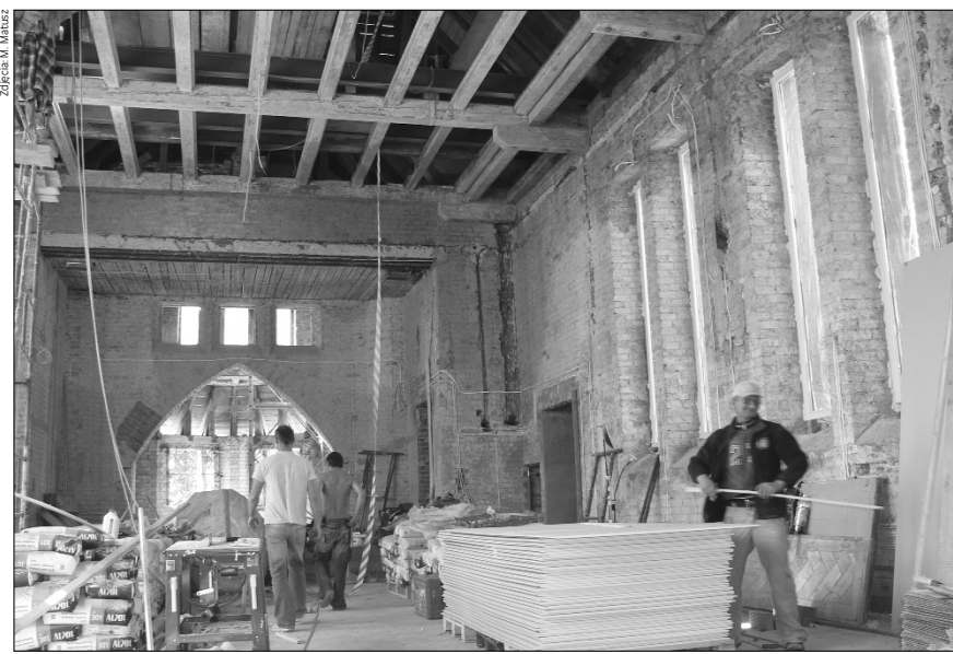
Wnętrze kościoła w czasie prac...
